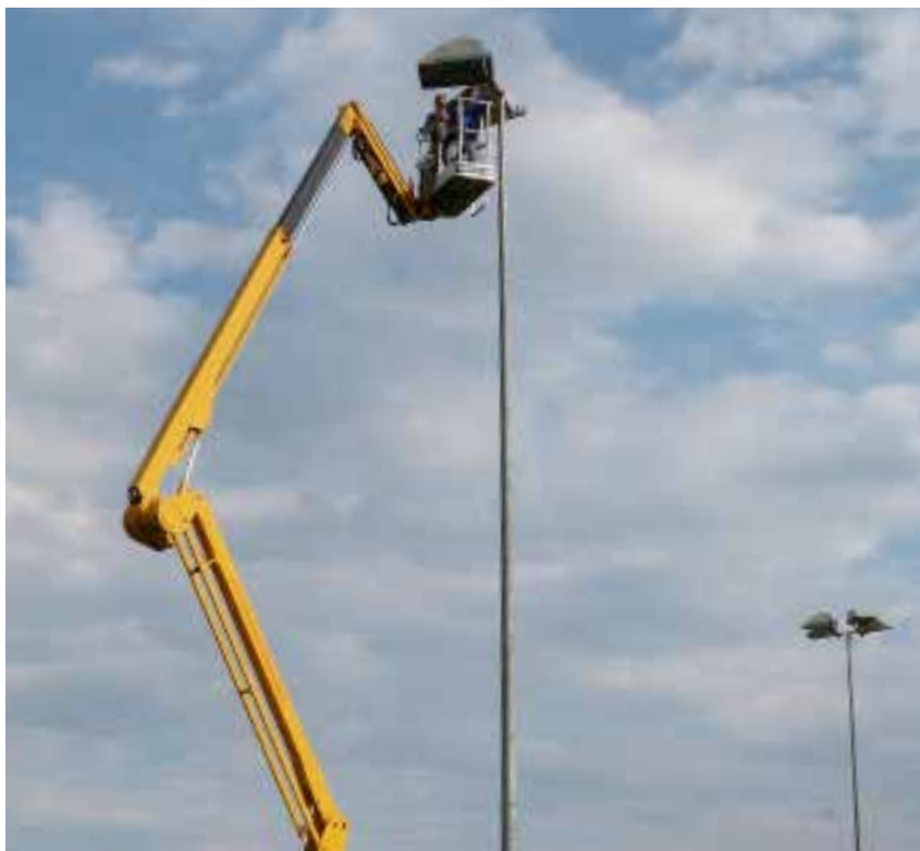
Von Zeit zu Zeit müssen die Lampen ersetzt werden, was arbeiten in luftiger Höhe bedeutet.
